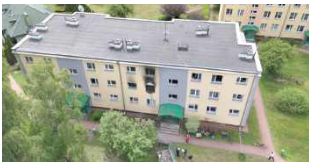
Na szczęście wybuch nie naruszył konstrukcji budynku
