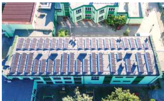
Na dachu szkoły zainstalowano instalacje fotowoltaiczną
