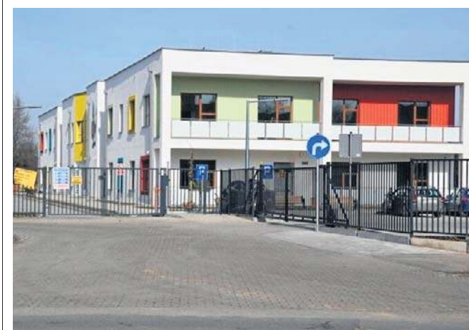
Nowy żłobek na Michałowie w Radomiu może przyjąć aż 220 dzieci, trwają odbiory techniczne budynku.
