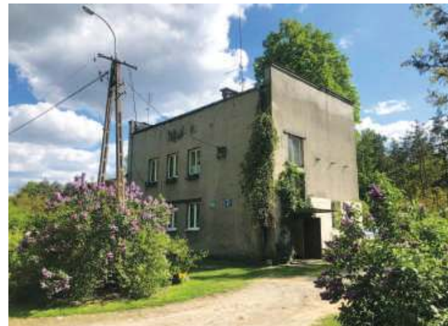
Dawny budynek stacji w Wójtostwie. Obecnie zaadaptowany na budynek mieszkalny
