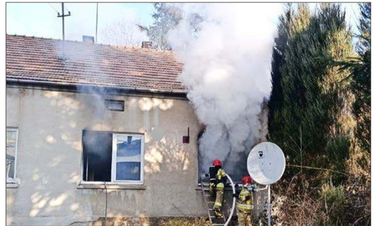
Pomieszczenie, w którym wybuchł pożar, zostało strawione przez ogień. Fot. OSP Pilzno.
