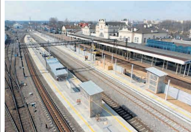
Trwa remont Dworca Głównego. Dwa perony są prawie gotowe
