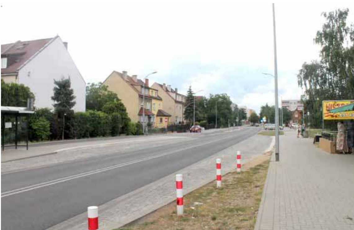
Beton dominuje również na ul. Wieniawskiego
