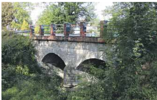
Za chwilę stary obiekt zniknie w powierzchni ziemi. Trwa wyburzanie mostu
