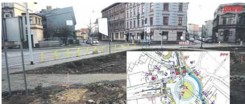
Przez dwa miesiące zamknięte będzie skrzyżowanie ulic Powstańców Śląskich, Styczyńskiego i Sienkiewicza w Tarnowskich Górach. Ruch w tym miejscu zamknięto wczoraj, 1 lutego. Objazd wyznaczono ulicami: Monte Cassino, Pokoju, Sobieskiego. (MIR)
