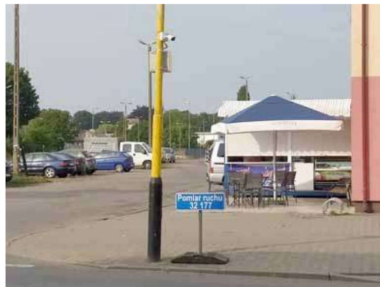
Urządzenie zostało zainstalowane na słupie oświetleniowym przy ul. 700-Lecia
