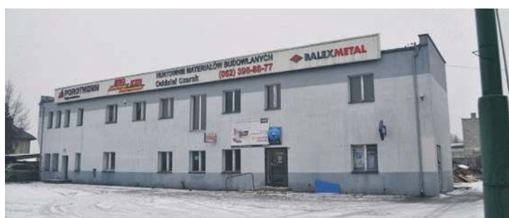
W skład zakupionej nieruchomości wchodzi dwie działki, budynek handlowo-usługowy oraz dwie wiaty magazynowe.
