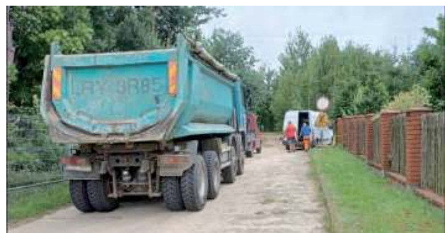
Przebudowa drogi gminnej przy ul. Ks. Brzóska ma się zakończyć w listopadzie
