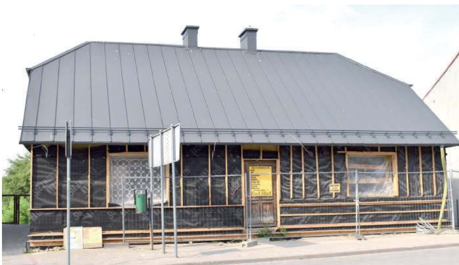
Prace przy przebudowie budynku dawnego przedszkola na siedzibę Centrum Integracji Społecznej miały zakończyć się w połowie ubiegłego roku. Niestety trwają do dziś, a mieszkańcy nie mogą korzystać z tak potrzebnego obiektu
