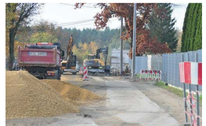
Budowa drogi w Specjalnej Strefie Ekonomicznej w Chrzanowie Kroczymiechu
