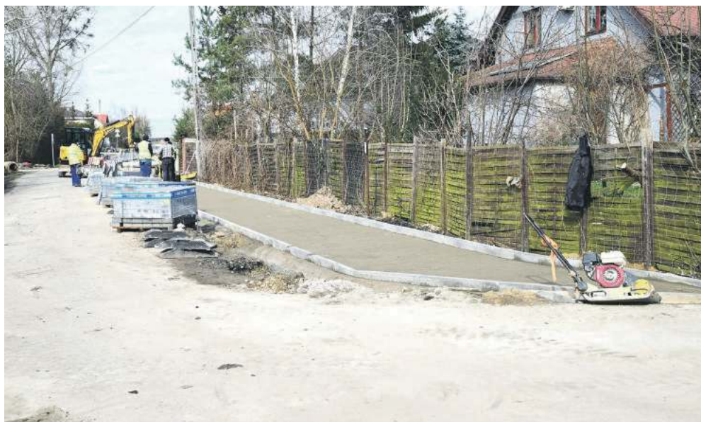
Budowa chodnika na ul. Stawowej w Rogożu
