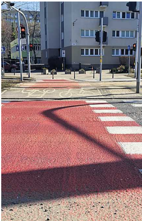
• Warszawa, Al. Reymonta: centymetrowy rysztok, krawężniczki, garby przy szynach, kolejny rysztok i krawężniczki.
