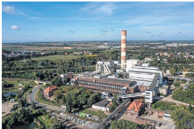
Koszt budowy nowego źródła wysokosprawnej kogeneracji to ponad 166 milionów złotych
