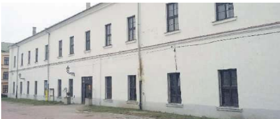
Budynek czeka na nowego wykonawcę.
