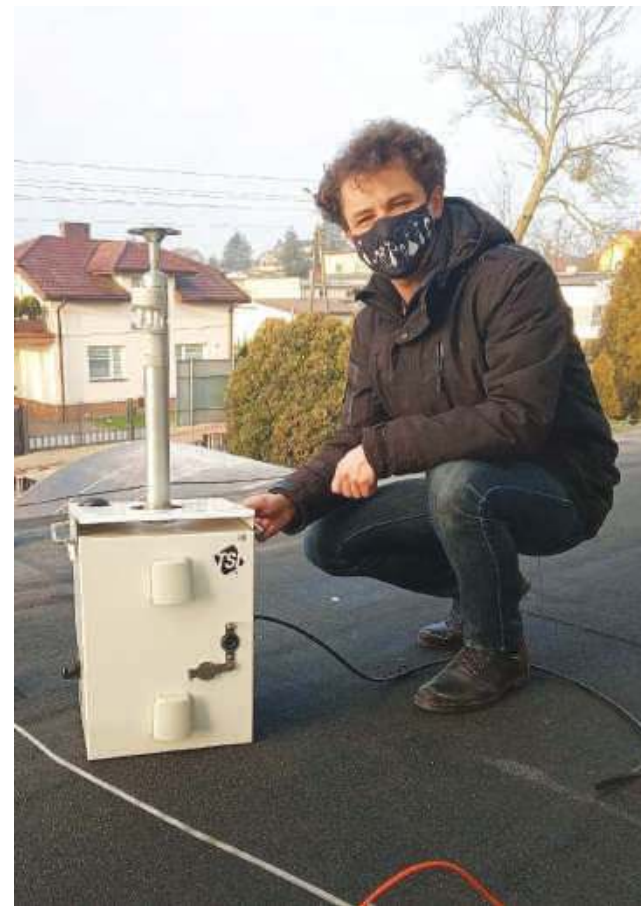
Montaż czujnika na dachu szkoły.
