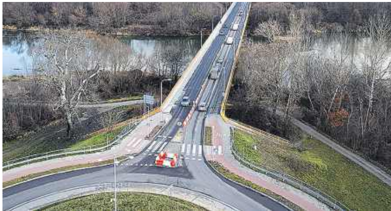
Na most na Sanie wraca ruch wahadłowy
