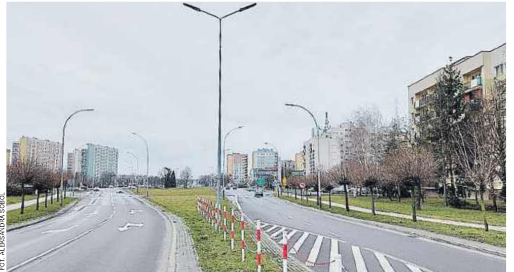
Ponad 200-metrowy odcinek ulicy KEN biegnący od ulicy Poniatowskiego do skrzyżowania z Al. Jana Pawła II w Stalowej Woli doczeka się przebudowy
