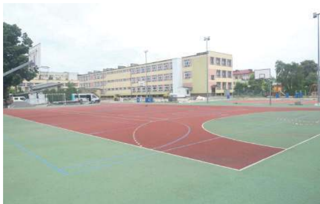
Projekt obejmuje między innymi budowę boiska do piłki nożnej o nawierzchni ze sztucznej trawy i boiska do gry w piłkę siatkową z nawierzchnią poliuretanową
