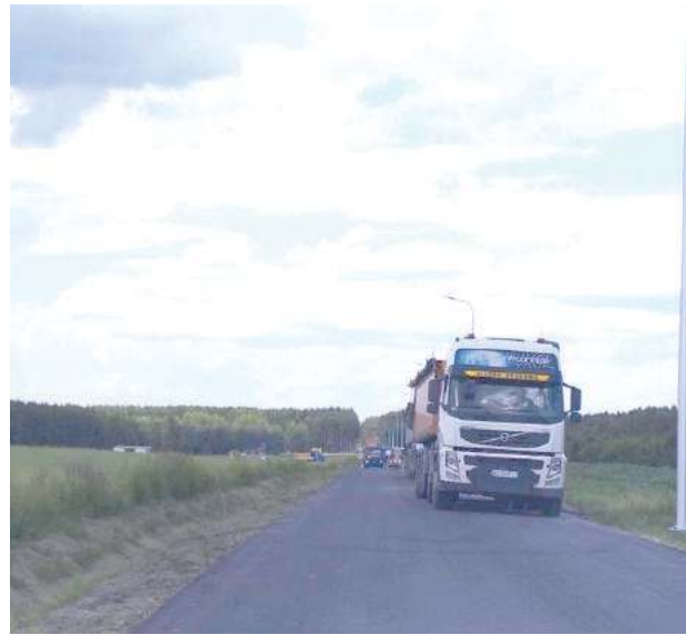
Przebudowana droga z Rakówki do Kulasz jest już niemal gotowa
