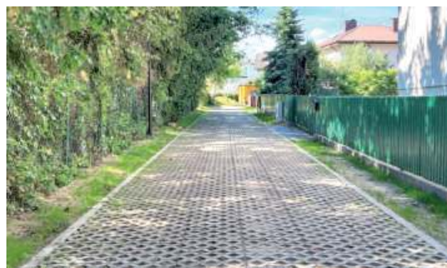
24 czerwca dokonano odbioru końcowego kolejnych inwestycji drogowych Osiedlu Rapy
