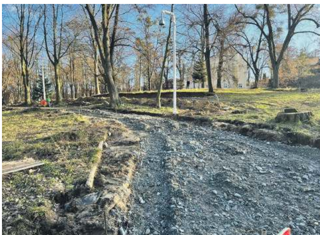
Tu dopiero położono podkład, który jeszcze nie został przysypany
