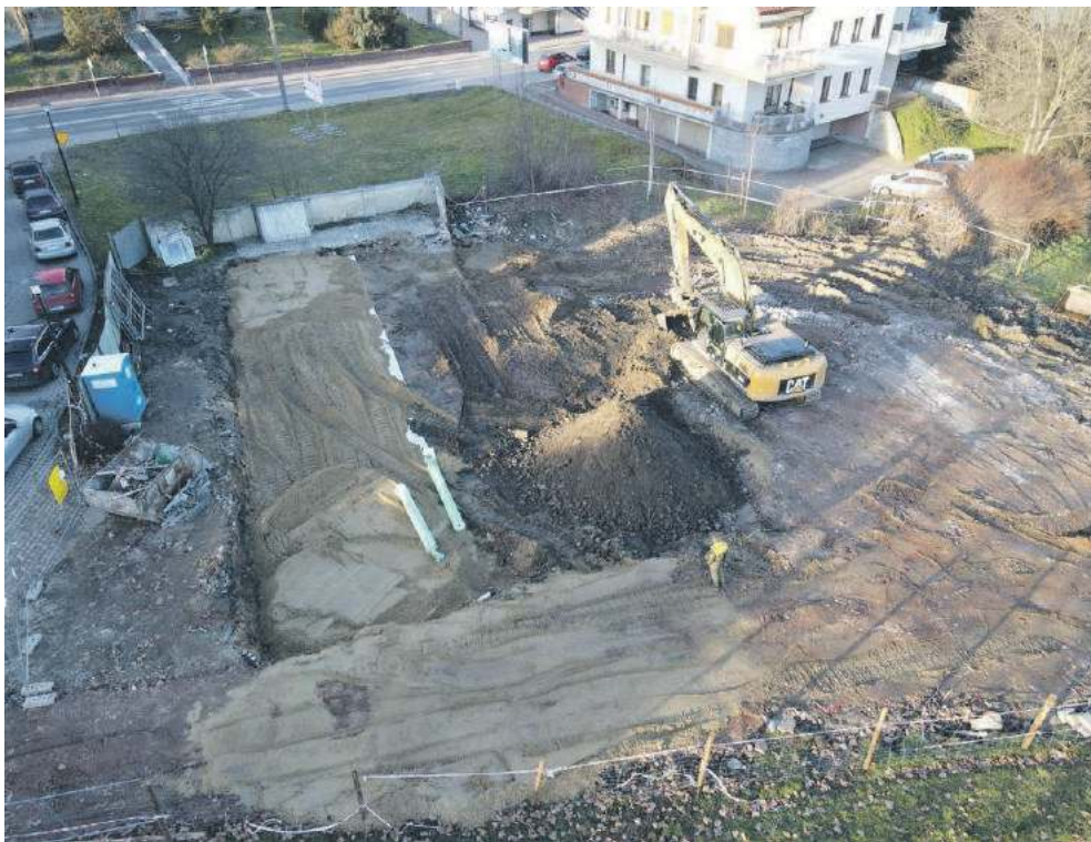
30 grudnia 2022, tak wyglądał plac budowy Biblioteki Miejskiej...
