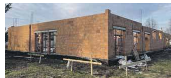
W Kaletach remiza ma już ściany
