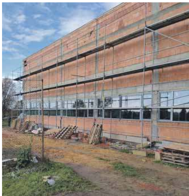
Przy szkole w Wojscie powstaje sala gimnastyczna. Inwestycja jest na finiszu
