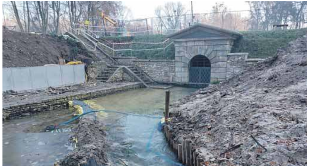
W październiku rozpoczęły się prace przy budowie ścieżki przyrodniczej do Bramy Gwarków
