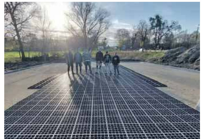
Pierwszy etap inwestycji w gminie Zbrosławice polegał na budowie parkingu na 39 miejsc
