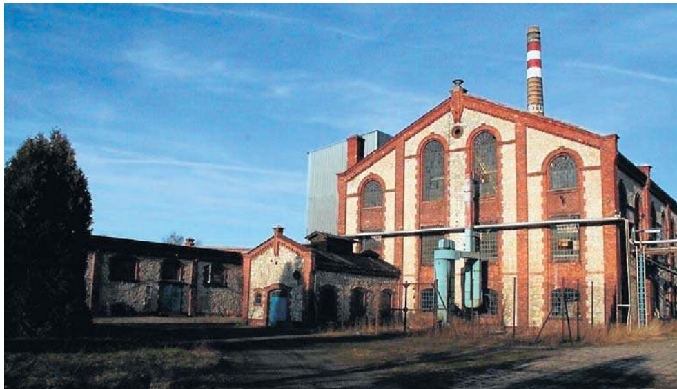
Hala produkcyjna wieluńskiej cukrowni ma ponad 100 lat - powstała w roku 1911
