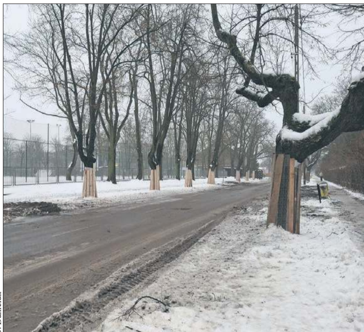
Przy przebudowie ul. Wyszogrodzkiej zostanie wyciętych kilkadziesiąt drzew. Te, które zostają, zostały zabezpieczone przed uszkodzeniami
