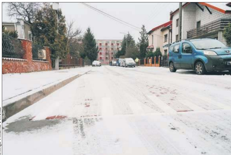
Zakończyła się przebudowa ulicy Konopnickiej na osiedlu Skarpa
