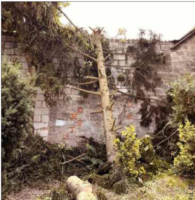
Drzewa po przejściu burzy zniszczyły wiele dachów. Tak było w Kolbuszowej Górnej.
