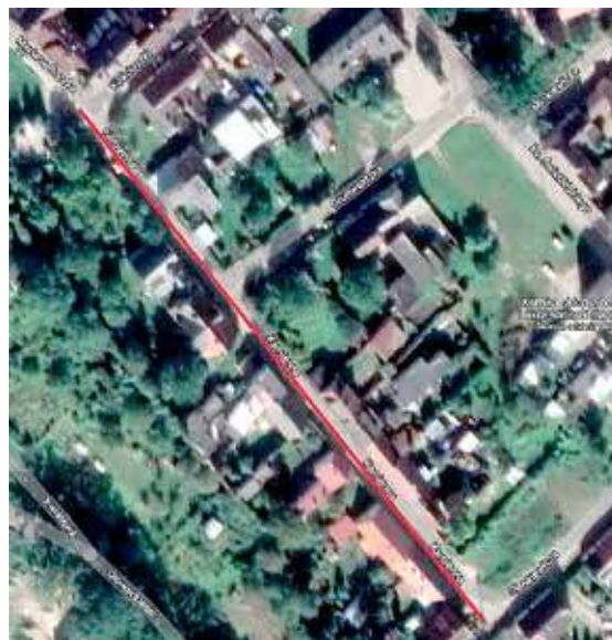
Odcinek drogi, który będzie przebudowany
