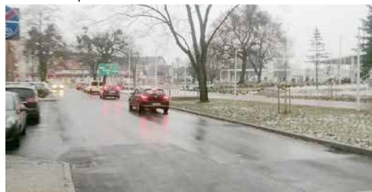
Temat remontu ulicy Dworcowej pojawił się w związku z wybudowaniem obok nowego dworca
