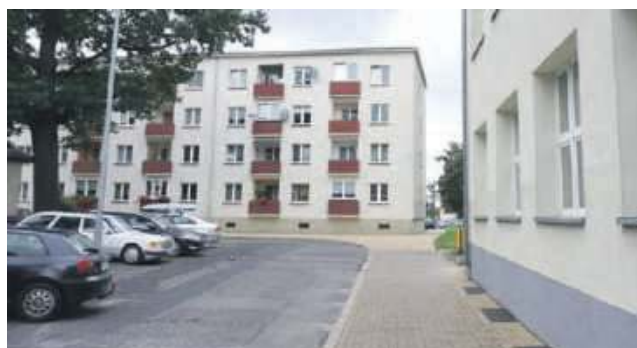
Blok mieszkalny w miejscu dawnego gruzowiska i ścieżki do sali gimnastycznej.
