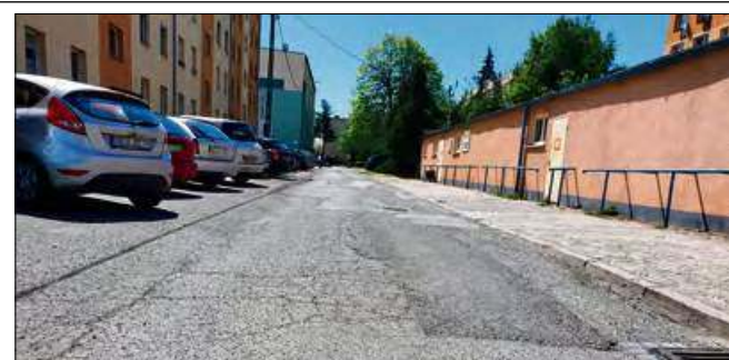
Droga zyska całkowicie nową nawierzchnię i odwodnienie.
