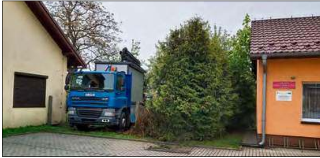
Wykonawca już rozpoczął prace.
