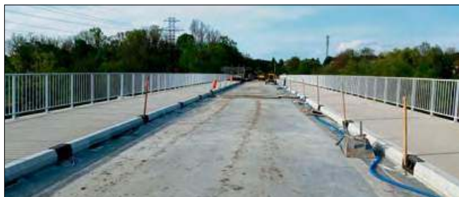
Postęp budowy robi wrażenie.
