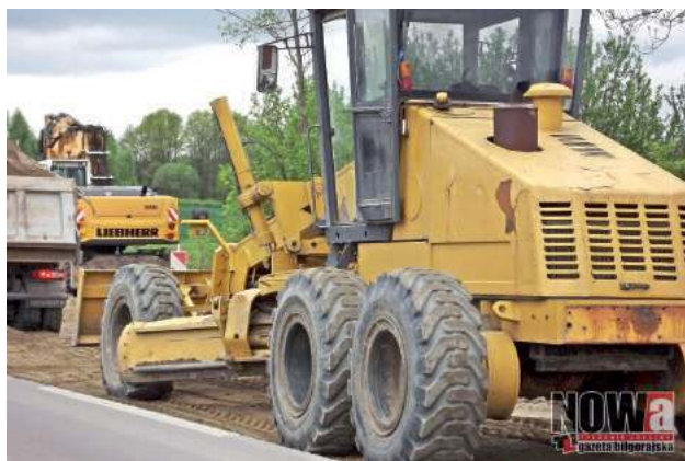
Łącznie gmina Józefów wybuduje ponad 500 metrów kanalizacji
