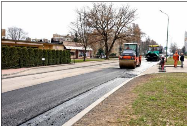
Ul. Ks. Piotra Skargi w remoncie.
