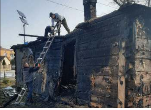
■ Wypalony dom nie nadawał się do remontu. Spaleniu uległo całe wyposażenie. Rodzina już rozpoczęła zbiórkę najważniejszych rzeczy. Pomóc może każdy z nas
