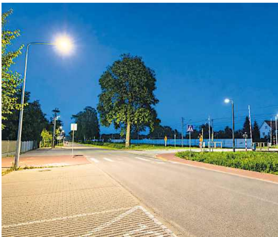
Kolejne miejscowości zyskują nowoczesne i energooszczędne oświetlenie.
