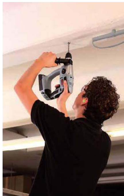
🔧 W stabilizacji pracy wiertarki pomaga dodatkowa rękojeść. YATO, LANGE ŁUKASZUK (KRESS)
