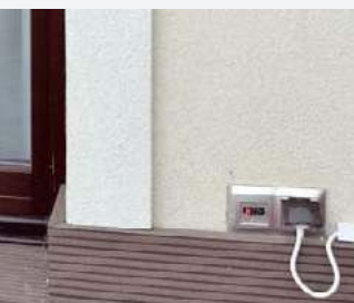
➤ Odporne na czynniki atmosferyczne gniazda na tarasie.
