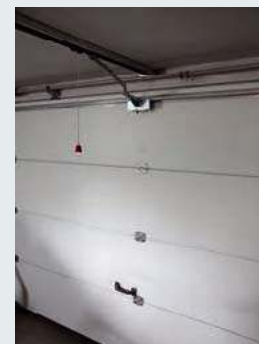
➡ Uszczelka nadprożowa, zawiasy na segmentach, wewnętrzny uchwyt, linka awaryjnego otwierania.
