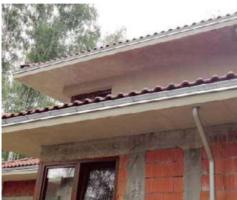
🔗 Często błędem projektowym jest zbyt mała liczba rur spustowych. T. RYBARCZYK
