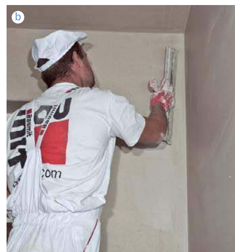
Przed nałożeniem tynku konieczne jest zagruntowanie podłoża (a), a po wyschnięciu jego wszystkich warstw – staranne wygładzenie (b). BAUMIT
