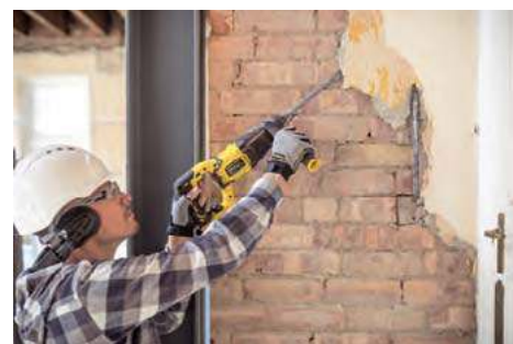
Kucie tynku przy pomocy młotowiertarki. STANLEY
