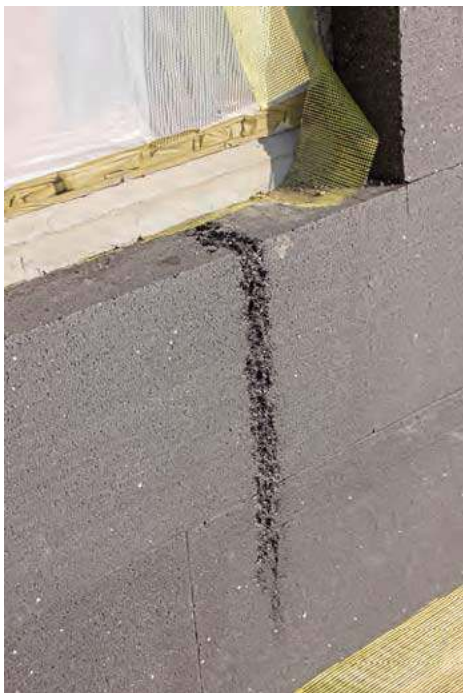
🔧 Szary styropian może nawet ulec stopieniu w miejscach gdzie jest intensywnie nasłoneczniony. ARCHIWUM PAWEŁ KRAUSE
