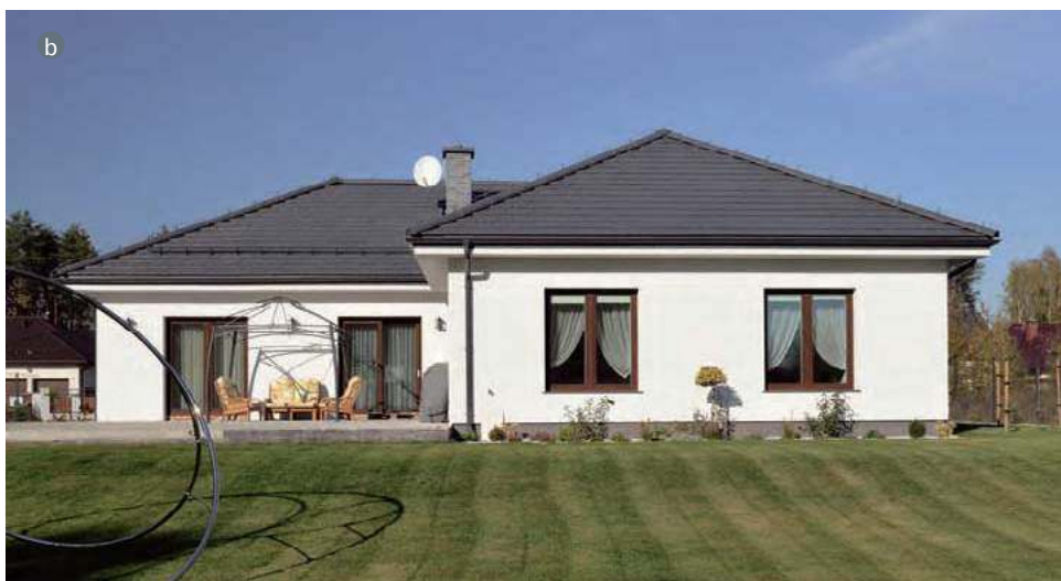
a Dla niewprawnego oka pokrycia ceramiczne i betonowe są nie do odróżnienia. Tu dachówki płaskie, pierwsza z betonu (a MONIER BRAAS), druga z ceramiki (b CREATON POLSKA).
