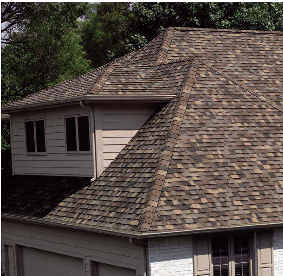
❷ Gont bitumiczny może być równie trwały, jak pokrycie z blachy. ARCHIWUM BD
