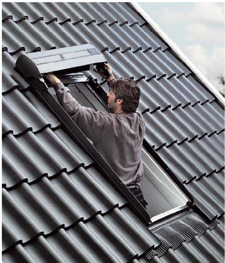
🔧 Montaż rolety dachowej. Najpierw przytwierdzana jest kaseta, a potem prowadnice boczne. VELUX
