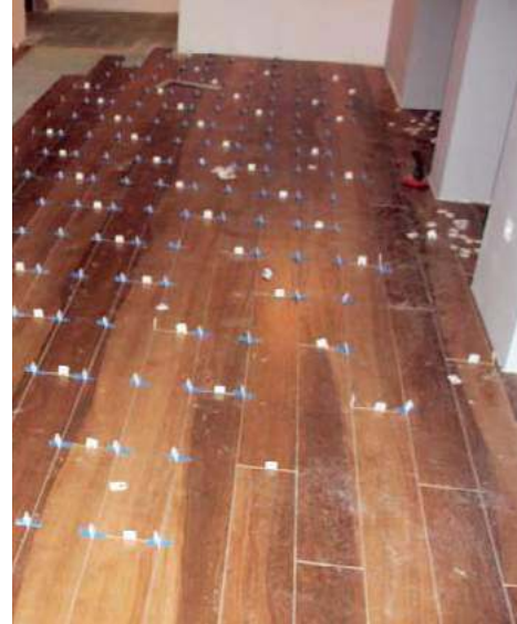
Przy układaniu posadzki z płytek niezbędne są krzyżyki dystansowe. AS
