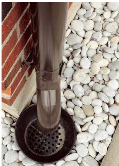
🔍 Sitko zapewnia drożność odpływu deszczówki np. do kanalizacji. RUUKKI
