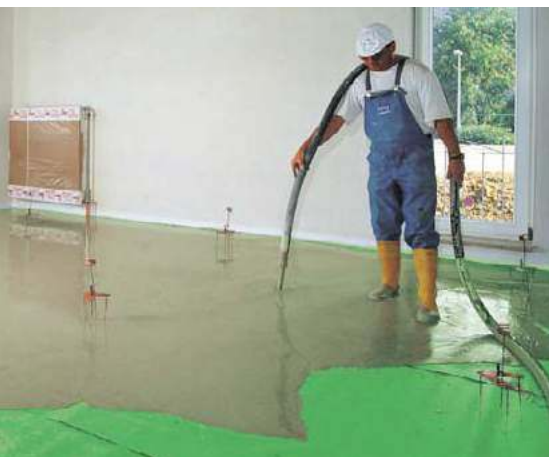
Podłoga na stropie drewnianym.
