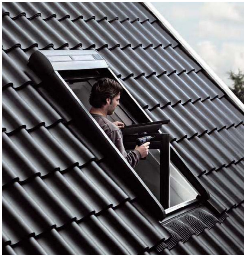
🔧 Montaż rolety dachowej. Najpierw przytwierdzana jest kaseta, a potem prowadnice boczne. VELUX
