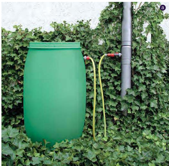
🔗 Zamontowany w rurze spustowej zbieracz wody z szybkozłączcem (a RHEINZINK) i łapacz, kierujący deszczówkę do zbiornika (b GARDENA).
