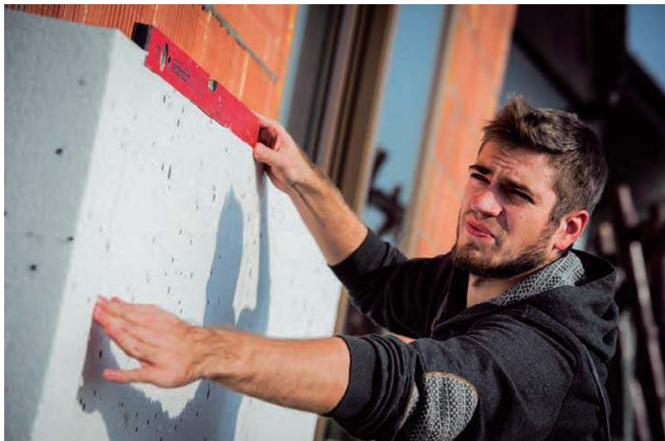
🔧 Wykonanie ocieplenia z białego styropianu wymaga jedynie staranności od wykonawców. Nie wymaga on zabezpieczenia przed działaniem słońca. TERMO ORGANIKA
