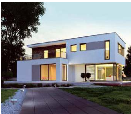
📌 Kruszywo dość często łączy się z innymi materiałami, np. betonowymi płytami traktując je jako dekoracyjne urozmaicenie nawierzchni. VESTONE
