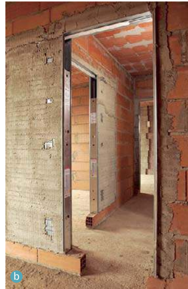
☞ Kaseta drzwi chowanych w ścianie przeznaczona do wykończenia płytami gipsowo-kartonowymi (a) oraz model do otynkowania (b). ECLISSE
