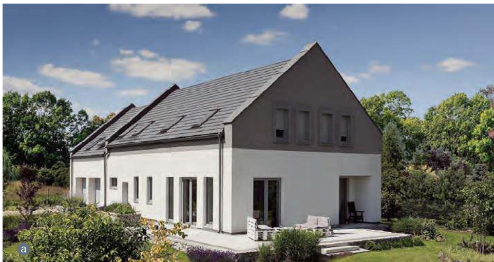
a Dla niewprawnego oka pokrycia ceramiczne i betonowe są nie do odróżnienia. Tu dachówki płaskie, pierwsza z betonu (a MONIER BRAAS), druga z ceramiki (b CREATON POLSKA).
