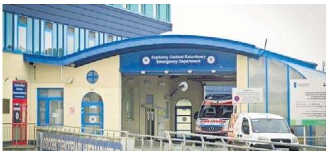
Wyjaśniano, że w rejonie SOR-u trzeba było wykonać remont
