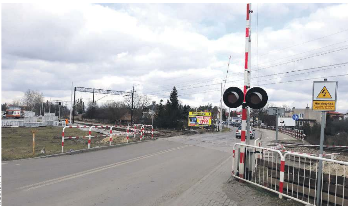
Przejazd będzie zamknięty od 16 do 21 marca, będą prowadzone prace związane z przebudową toru. Kolejne zamknięcia przejazdu planowane są na II połowę kwietnia (na okres około tygodnia) oraz w sierpniu i wrześniu (dwa zamknięcia na okres tygodnia)
