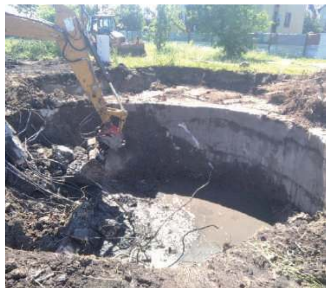
Budowa bloku komunalnego rozpoczęła się od niespodzianki
