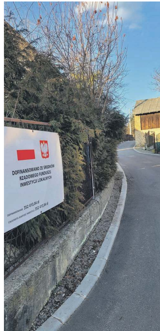
Kasztanowa w Czyżówce ma nową nawierzchnię, ale odwodnienia zrobić się nie dało. Woda z tej stromej uliczki splywa na ul. Długą i posesje położone naprzeciwko
