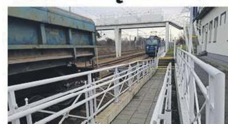
Ten wygodny podjazd dla niepełnosprawnych na libiąskim dworcu PKP prowadzi wprost do...
