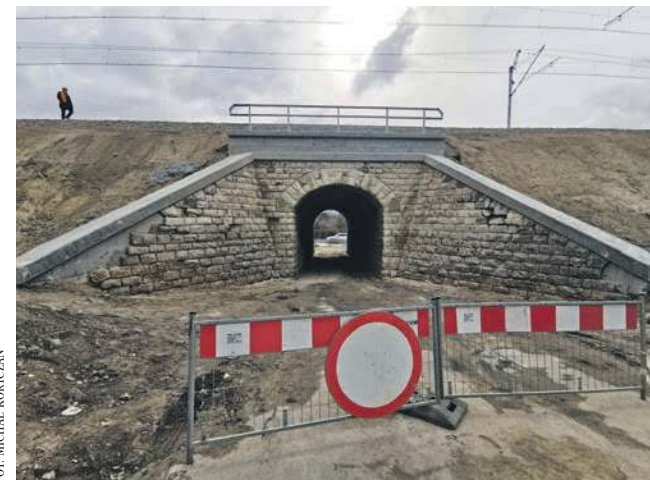
Wiadukt na ul. Krasickiego w Chrzanowie
