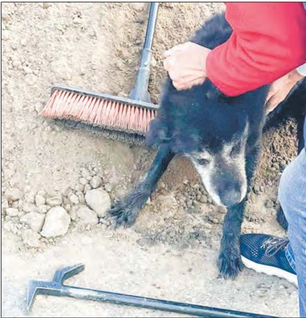
■ Strażacy z OSP Stary Pilczyn i PSP Garwolin przez dwa dni walczyli o uwolnienie psa, który utknął głęboko w rurze kanału burzowego. Konieczne było użycie koparki
