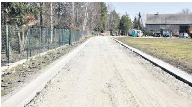
Na ulicy Malinowej w Psarach trwają prace związane z odtworzeniem nawierzchni drogi po budowie kanalizacji sanitarnej
