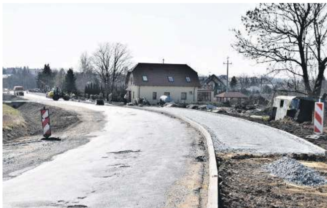
Budowa ciągu pieszo-rowerowego wzdłuż ulicy Strzeszowskiej w Szewcach (droga powiatowa nr 1367D) od skrzyżowania z ulicą Sportową do cmentarza
