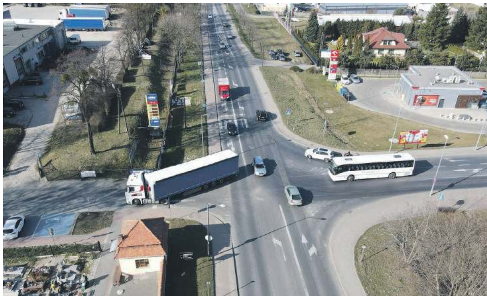
Na razie na skrzyżowaniu nie widać jeszcze pracowników. Kiedy ruszą prace i czy zakończą się w terminie czyli mniej więcej do końca wakacji?
