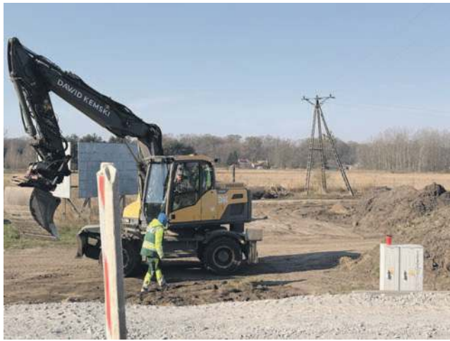
Budowa ścieżki rowerowej trwa
