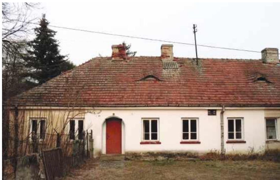
Zabytkowa oficyna przy ruinach pałacu
