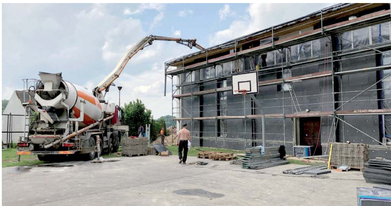
Prace remontowe w Zespole Szkolno-Przedszkolnym zostały już rozpoczęte. Firma Probatas z Poniatojewiczy ociepli salę gimnastyczną oraz robi modernizację parkietu. Jeżeli wszystko pójdzie zgodnie z planem, to inwestycja zostanie ukończona w październiku
