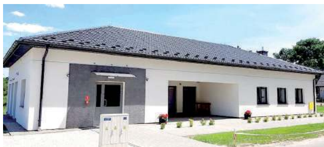
Nowoczesny budynek świetlicy w Zagrodach będzie teraz służył również najmłodszym mieszkańcom sołectwa
