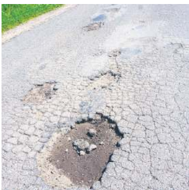
Droga do Sowiej Góry fot. Sej
