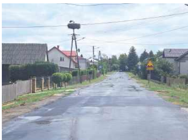
Jedną z dróg na terenie gminy Puławy, która w najbliższym czasie przejdzie remont, będzie ul. Kolejowa w Gołębiu
