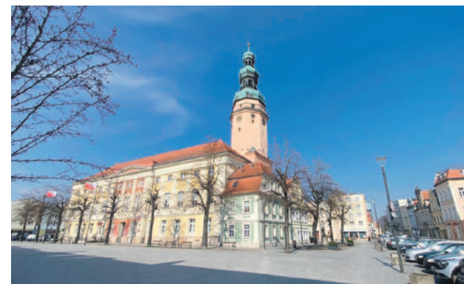
Strona południowo-wschodnia ratusza. Zdjęcie zrobiłem 22 marca 2026. Na drzewach nie ma liści, więc budynek ratusza jest bardzo dobrze widoczny
