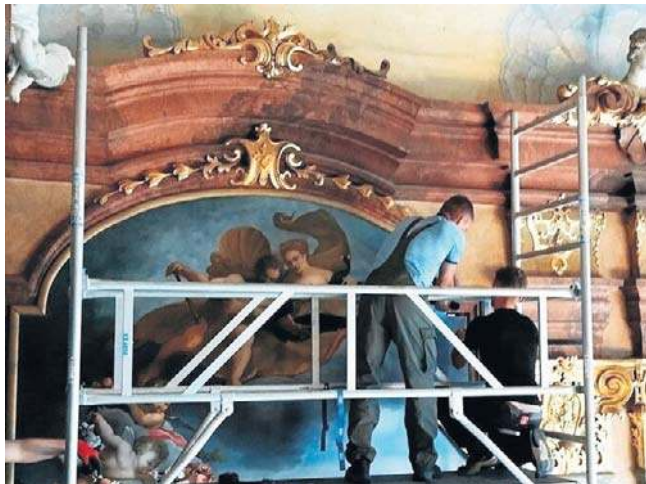
Pracownicy musieli dobrze dopasować maskujące ramy, wykonane z dębowego drewna. Zadanie było bardzo trudne.
