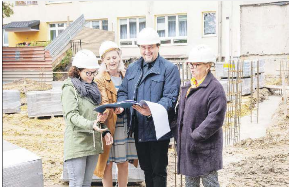
Jedną z najważniejszych inwestycji rozpoczętych w zeszłym roku była długo wyczekiwana budowa żłobka wraz z termomodernizacją budynku Przedszkola Samorządowego nr 1 w Łosicach
