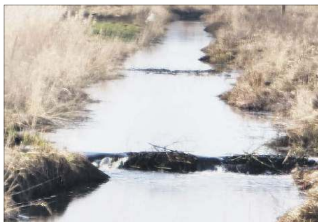
– Wody Polskie starają się na bieżąco działać, ale bobry ciągle odbudowują tamy – mówi Mateusz Majewski . Na zdj. rów w Mokrych w gminie Rossosz
