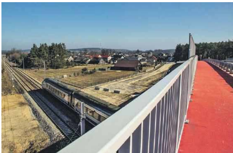
Kozia Wieś - nowy wiadukt nad torami CMK zwiększył poziom bezpieczeństwa ruchu kolejowego i drogowego oraz usprawnił komunikację
