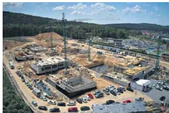
Świętokrzyski Kampus Laboratoryjny Głównego Urzędu Miar w Kielcach (w budowie).
