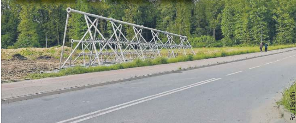
Zamontowane na maszcie anteny mają poprawić zasięg w trzech miejscowościach.
